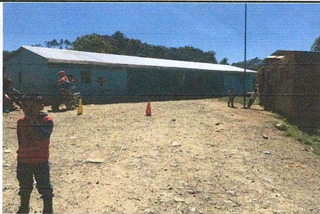
Foto 1: vista del modulo 3
